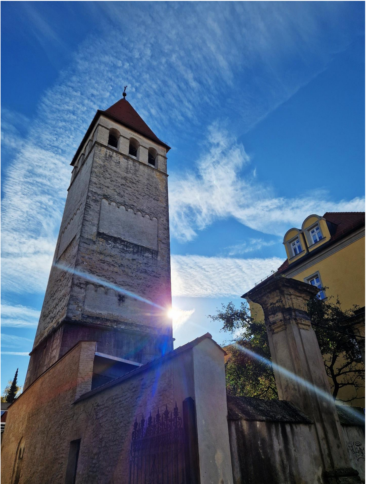
(„Glockenturm, freistehende "Campanile" an der Obermünster-Ruine in Regensburg ©Christian Scheinost)
